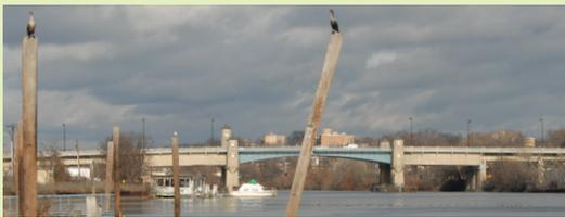
El puente levadizo en la ruta nacional 46 sobre el río Hackensack, en Little Ferry, fue elegido para conformar el Registro Nacional de Lugares Históricos en 1997. Construido en 1934, es un puente levadizo de doble hoja con plataforma de muñón de viga, con dos secciones móviles, que puede abrirse para permitir el tráfico de barcos. El puente levadizo en la ruta nacional 46 tiene importancia tecnológica, como ejemplo de un estilo de puente cada vez más raro y bien conservado.
